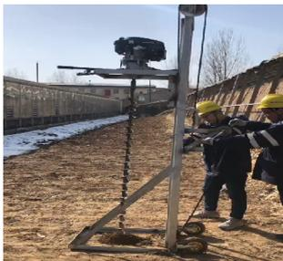
图4 接地极钻孔装置
